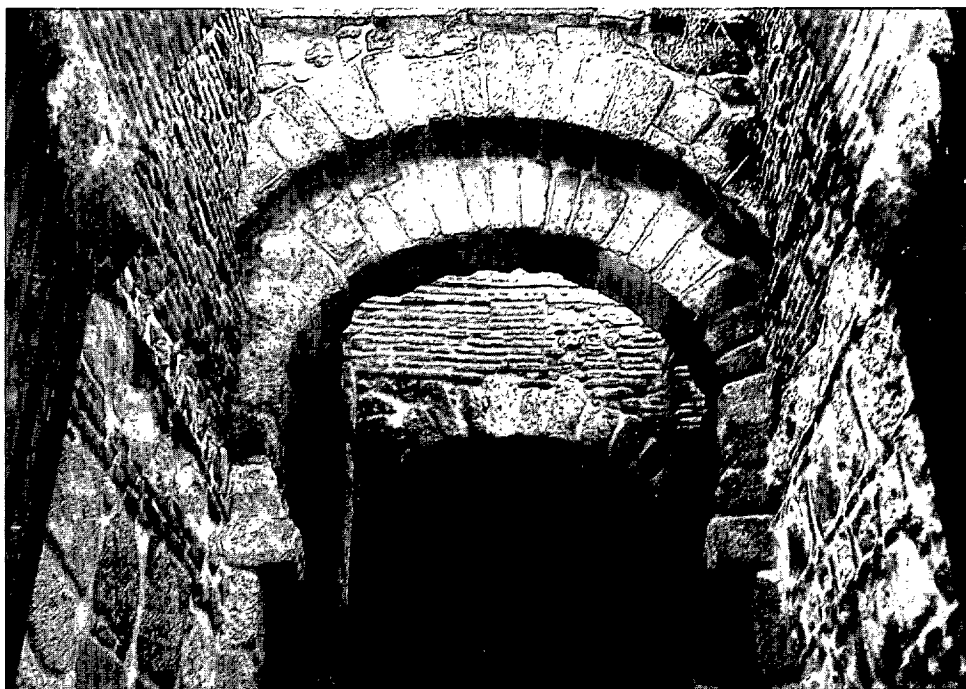
Conjunto de arcos califales a la entrada de la iglesia parroquial de Santa María de los Alcázares (Maqueda).
