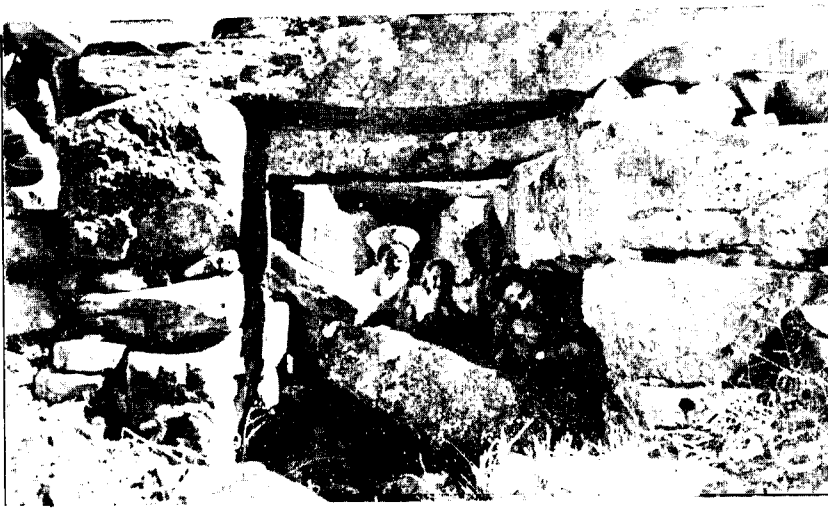
"Sala de los Moros". El pasillo transversal, antes de su des- escombro. A la de- recha se observa la entrada del pasillo largo.
