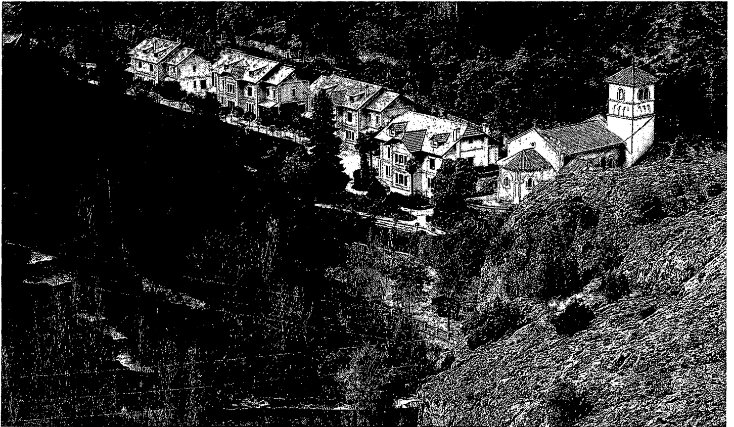
Central Hidroeléctrica de Villalba (Cuenca).
